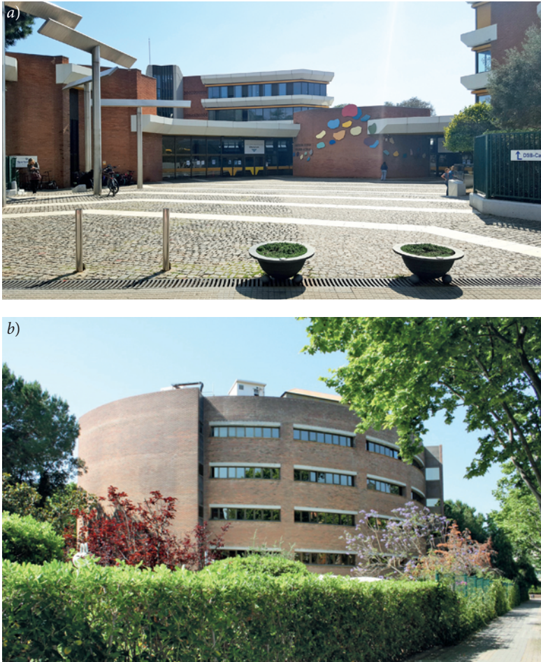
FIGURA 9. a) Vista del Col·legi Alemany de Barcelona (1974); b) vista del centre docent Escola Superior d'Administració i Direcció d'Empreses (1985) al carrer del Marquès de Mulhacén de Barcelona. FONT: a) Fotografia de l'autor, 2025; b) fotografia de l'autor, 2021.
